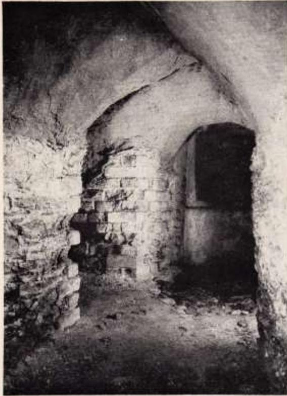
Abb. 22: Die linke (hintere) zum Brunnen führende Strecke unter Schloß Hinterglauchau mit Blick auf die Brunnenöffnung. Auch hier ist die aus Ziegel- und Bruchsteinen bestehende Untermauerung sichtbar.
