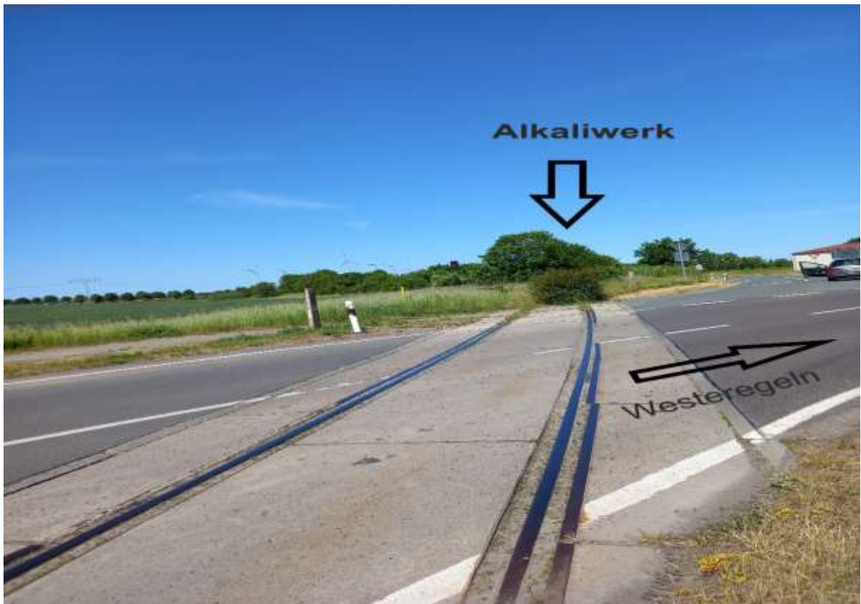
Rest der Schienenanlage zum Werk
