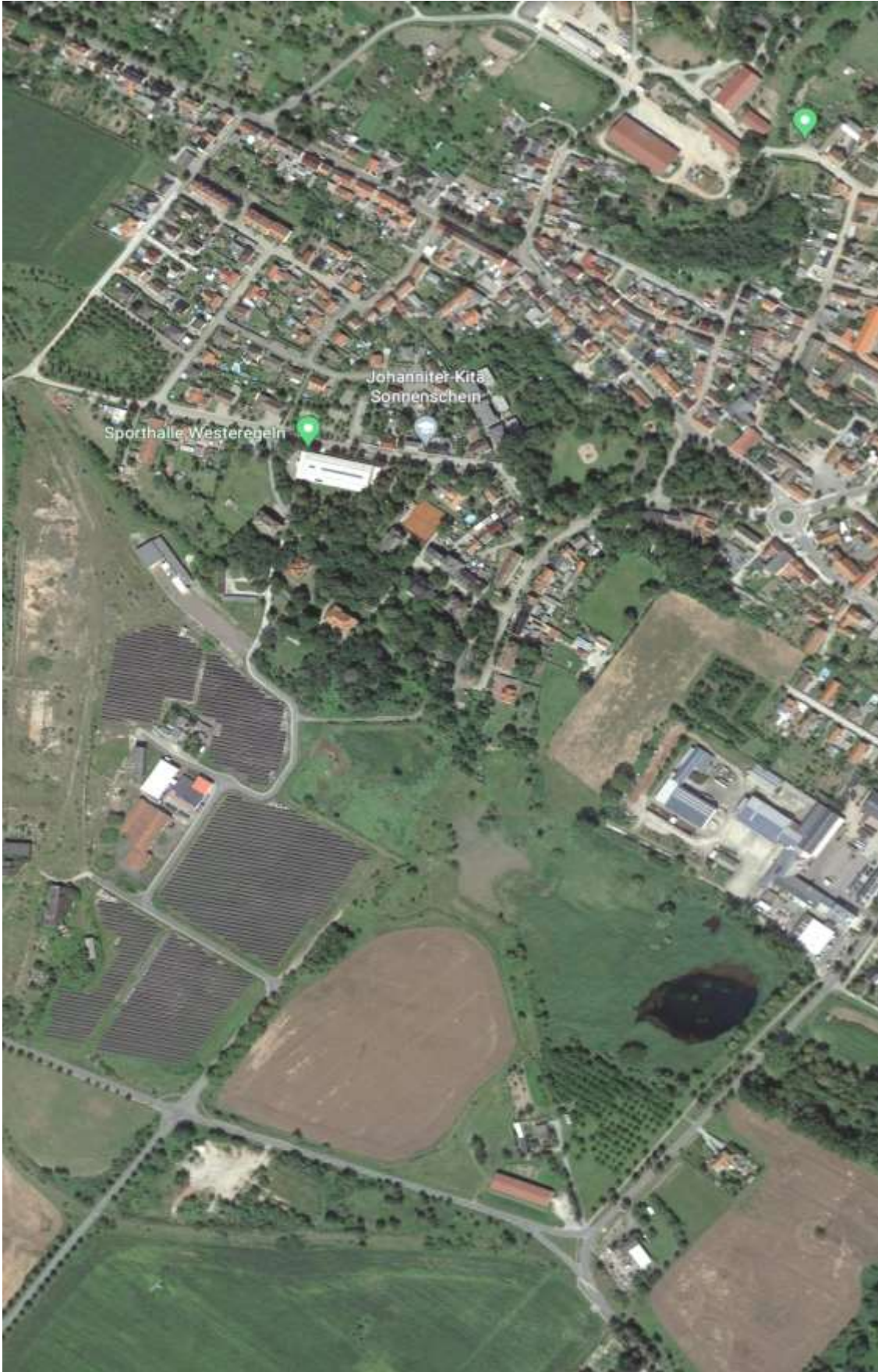
Der Zustand des Gebietes mit Erdfall, Goethepark und ehemaligen Alkaliwerk
