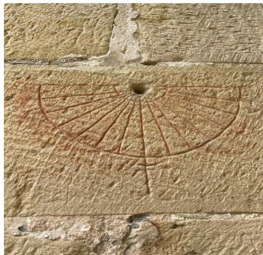
Foto der Sonnenuhr DGC 512, mit schräger Mittagskerbe in der Einbaustelle.
