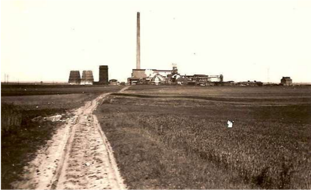
Braunkohlengrube Cäsar mit Kraftwerk und Naturzug-Kühltürmen
