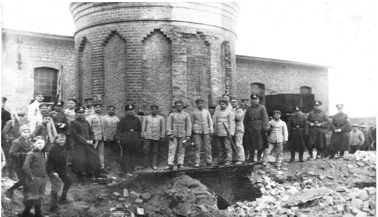
Vorbereitung der Sprengung eines Schornsteines 1937\ Privatfoto\ Ausschnitt H. Bartzack\
